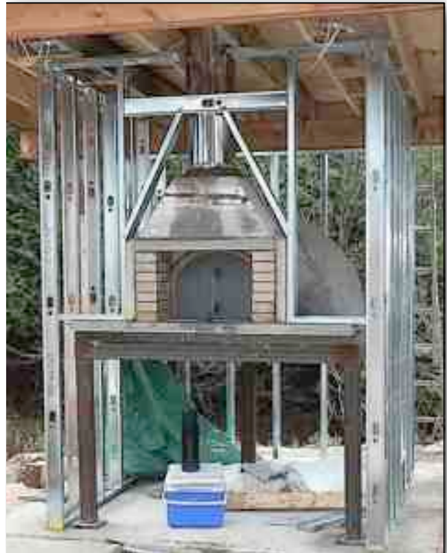
2.5. Custom metal stand with stud frame.
