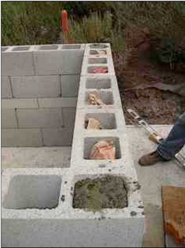
2.6. Filling the cores.
